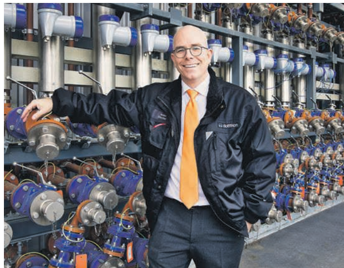
Markus Blocher beim Rohrleitungsbahnhof der neuen Produktionsanlage (Quelle: DES)
