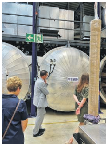
Messwandler im Lagerraum
