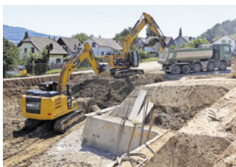
Erdarbeiten mit dem breiten und modernen Maschinenpark
