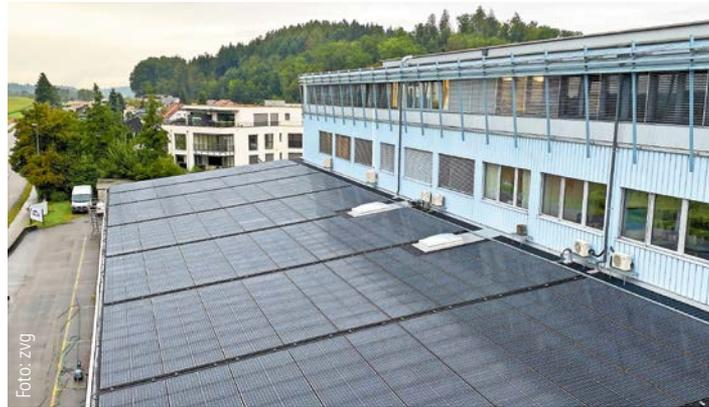
Photovoltaikanlage mit 519 Modulen und einer Leistung von jährlich 200 000 kWh
