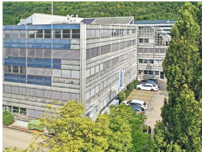
Niederlassung Biel der Rotodur AG
