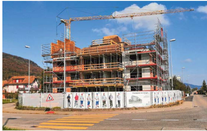
Die Baustelle mit den Plakaten der Lernenden
