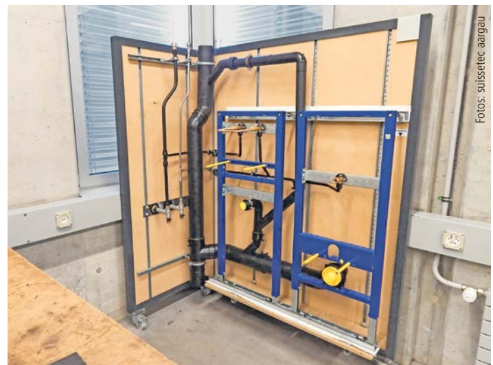
Badezimmeranschlüsse des Sanitärinstallateurs EFZ
