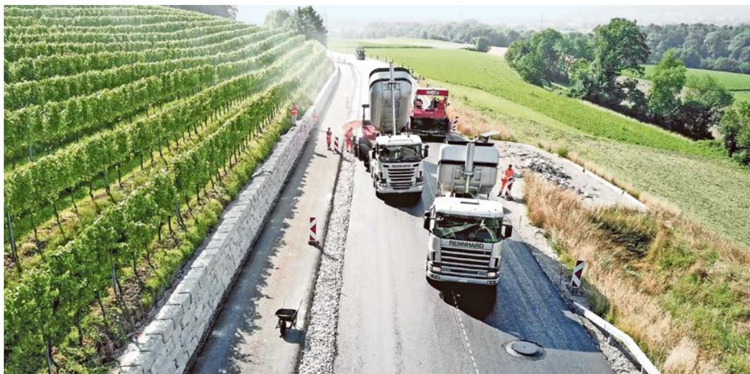
Im Aargau hat sich der Einsatz von Recyclingbaustoffen im Strassenbau bereits etabliert. Foundationen und Beläge werden wo möglich mit Recyclingbaustoffen realisiert.
