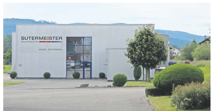
Ostansicht des Geschäftsgebäudes.
