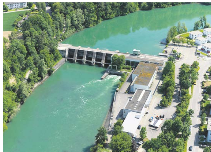
Kraftwerk Bremgarten Zufikon.
