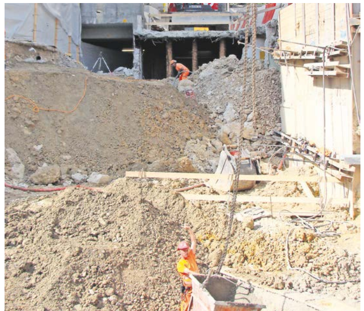
Schulhausplatz Baden, eine der grössten Baustellen im Kanton Aargau.
