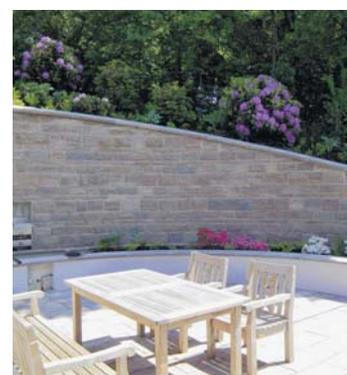
Muschelkalk-Schichtenmauerwerk mit Mörtelfuge und Abdeckplatten. Vorgesetzte Pflanzrabatten und integriertes Wasserspiel.
