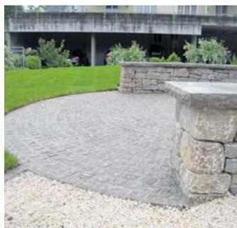
Kreisplasterung und Wechsel-schichten-Mauerwerk als Sitzmauer gestaltet
